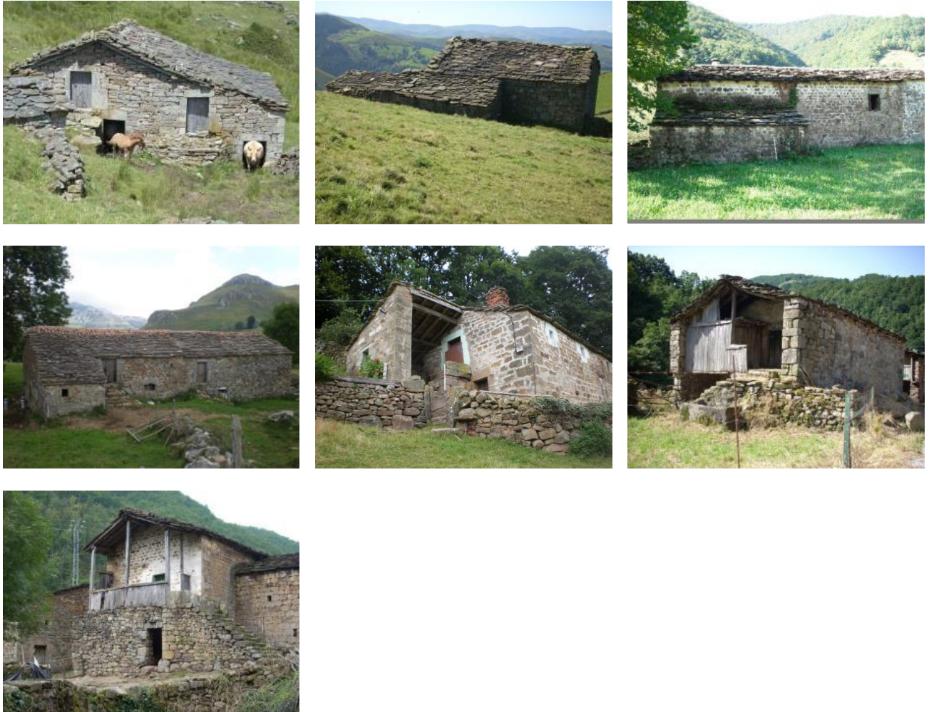
Ampliaciones de cabañas realizadas mediante diferentes sistemas tradicionales
