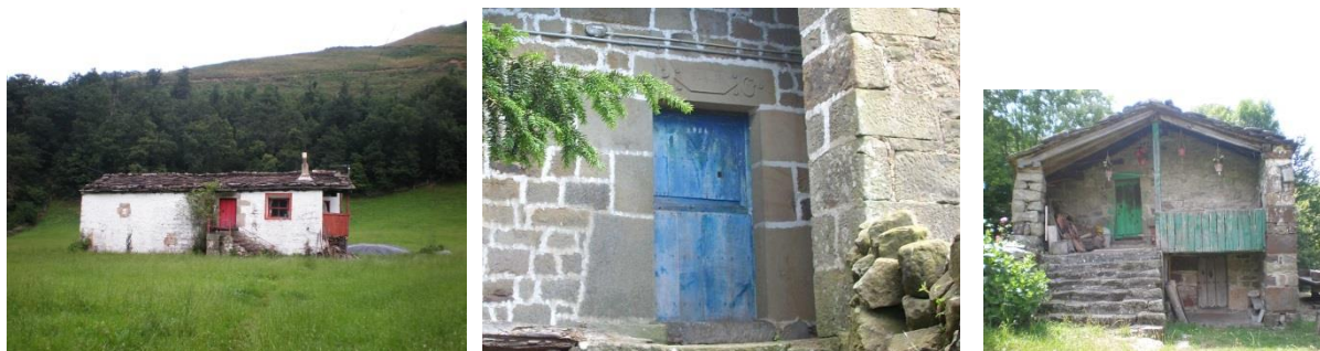
El uso del color en los muros y carpinterías
