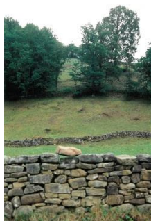
Muro de cierre de mampostería a junta seca
