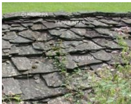
Ejemplo de cubierta de lastras
